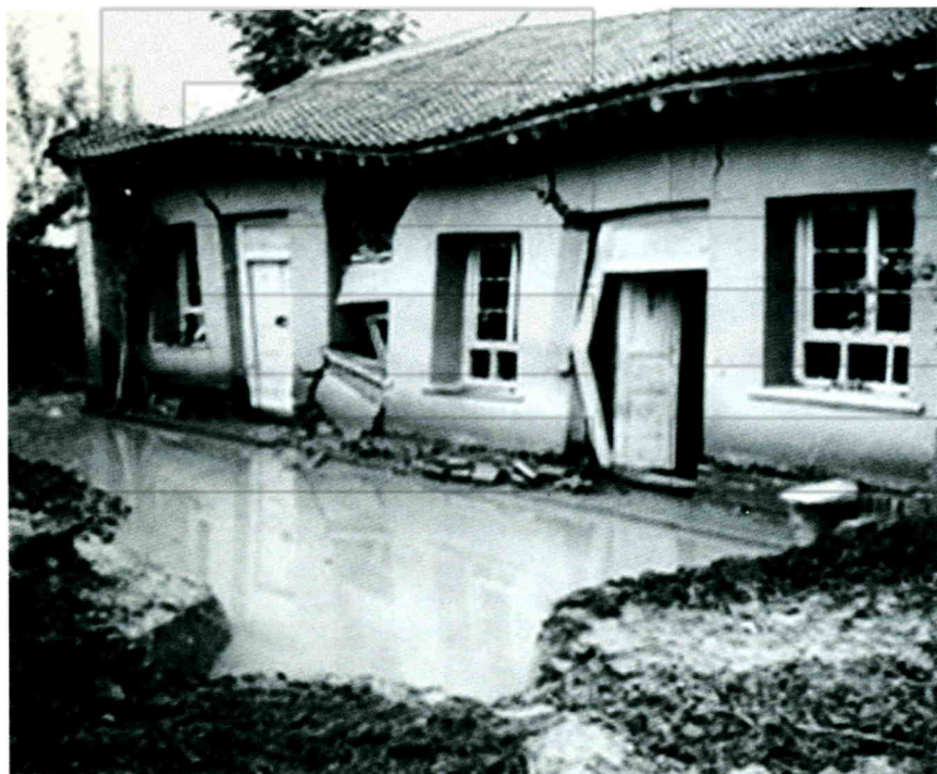
暴雨损坏的房屋（甘肃，1992年8月8日）
