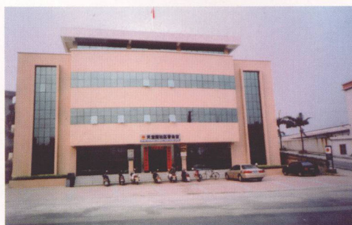
治安综合大楼
