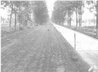
图 1-5 某试验路级配碎石中间层
