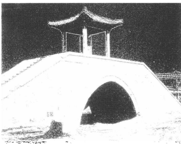
图十五 唐洛阳城为隋炀帝所兴建，城廓长七十余里，人口多达二十万余户，到武则天定都洛阳时，人口又增长许多。洛水流经该城，将城分割成南北两半，皇城和宫城位在城北的西区，官吏入宫办事必经洛水的天津桥。天津桥是用数百艘小艇链锁成的一座浮桥。图中是后人在天津桥遗址所建的石砌拱桥，非复当年面貌。
