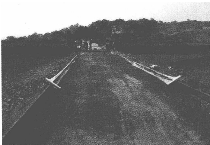
图 1-3 正在施工的路基
