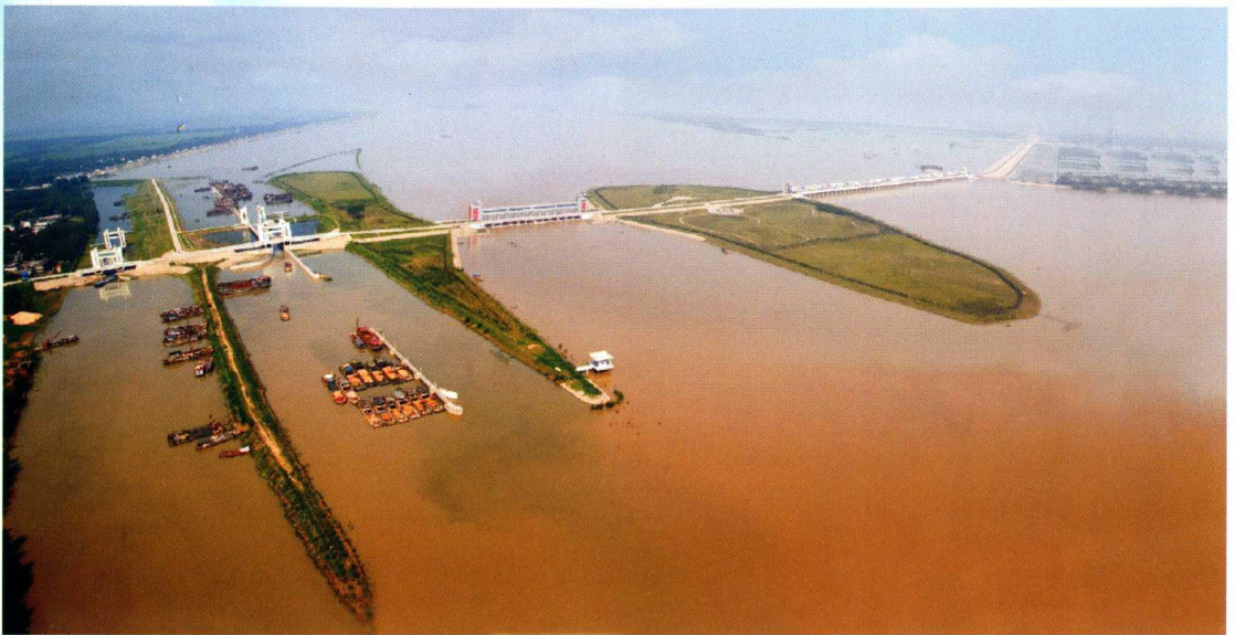
淮河临淮岗洪水控制工程
