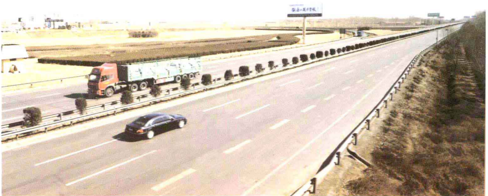
贯穿玉田全境的京沈高速公路
