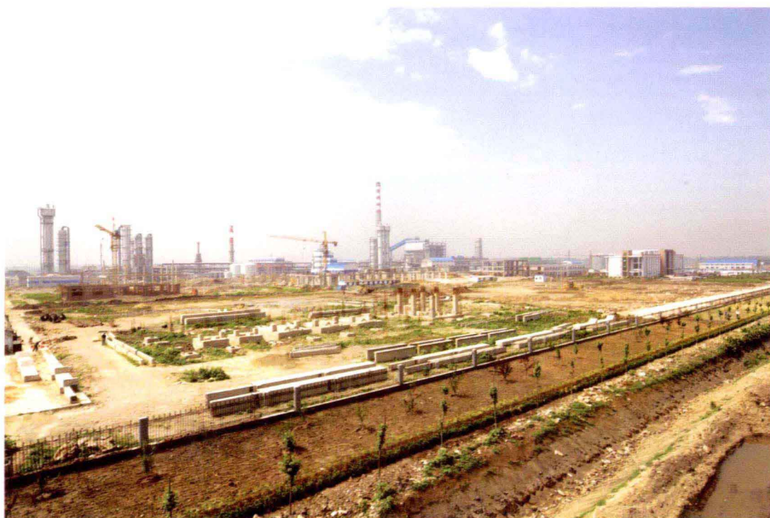
正在建设中的后湖工业聚集区
