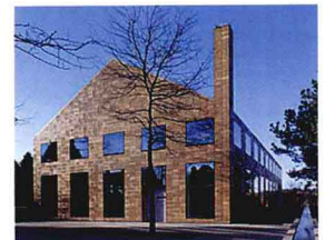
40. Kantoorgebouw in 't Gooi Koen van Velsen Laren, 2006
