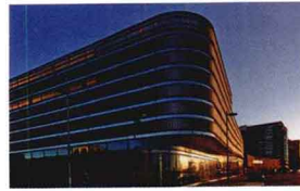
29. Veranda Car Park Paul de Ruiter Rotterdam, 2005
