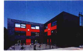
24. Community School Het Spectrum Architectenbureau Marlies Rohmer The Hague, 2005
