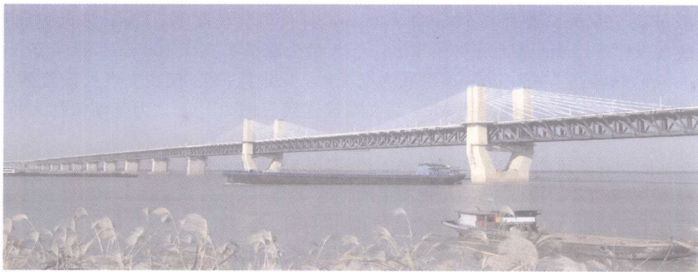
图1-1-1 芜湖长江大桥
