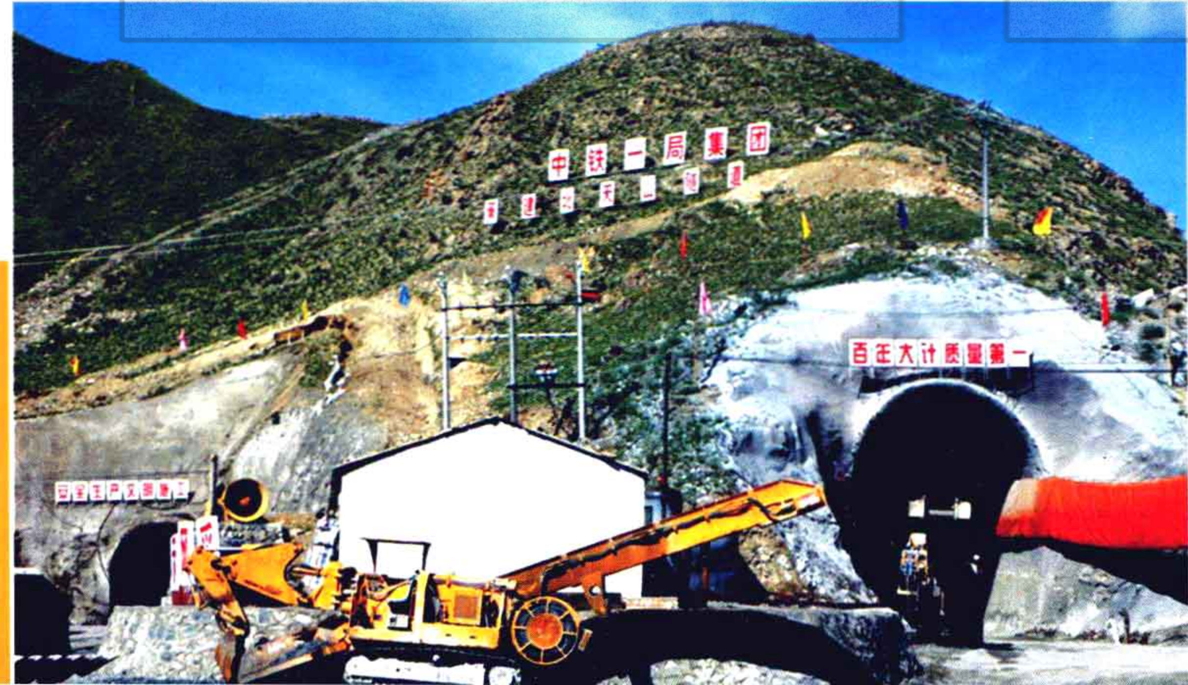
精伊霍北天山特长隧道进口施工 工地 李华东摄
