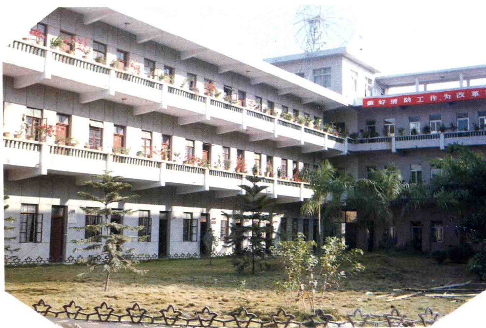
东坑镇政府办公大楼
