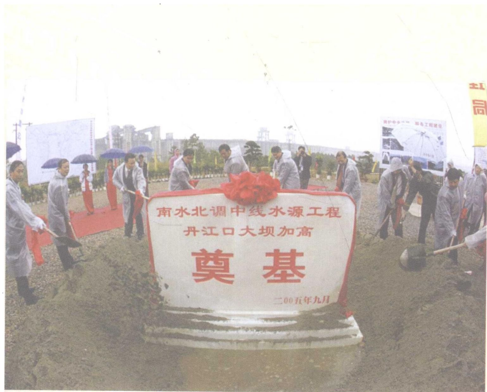
丹江口水库大坝加高奠基
