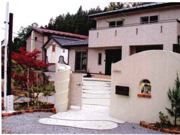
↑ 门柱是龙卷风形状的设计。门扉采用“板壁”建造,和建筑物很搭配。
