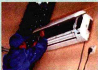
灰尘和细菌穿过过滤网进入空调内部，与冷凝水黏合后堵塞在蒸发器上，便影响空调的制冷和散热。而这些脏东西藏在蒸发器铝片的缝隙中，从表面根本就看不到，需要用专用的空调清洗剂才能清洗干净。空调清洗后，
