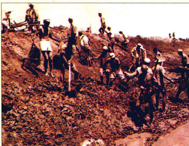
深挖排渠、开垦万古荒原
