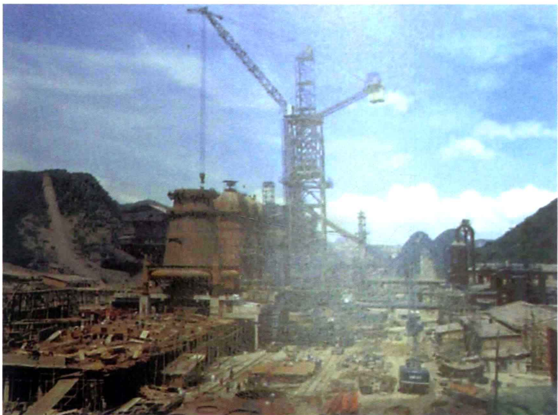
1976年，建设中的水城钢铁厂。
