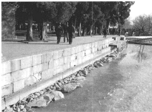
图 1-5 颐和园东堤条石驳岸及其构造 (来源:《园林工程》)
