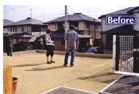
① 施工前的庭院还只是一片空地。什么都没有。建筑物容易被天然砂土扬起的尘土弄脏，清理起来也很麻烦。
