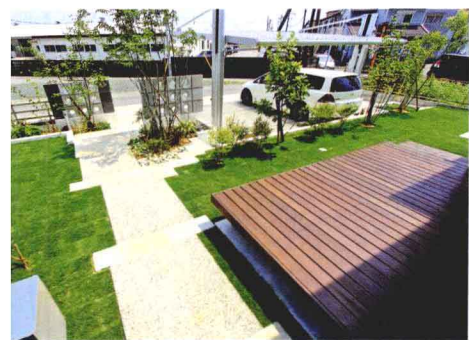
↑ 庭院的小路由水洗石和平板石块组合构成。
