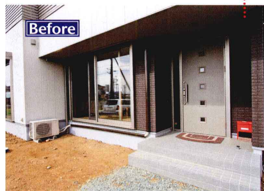
施工前的样子。目标是把它变成美丽的庭院！
