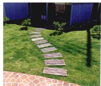
⑧ 混凝土制成的枕木小道。
