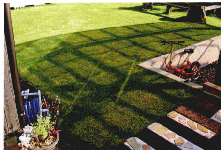
通道上交替地铺设上枕木和石块。里面是用枕木铺设的能容纳一辆车的停车场。
