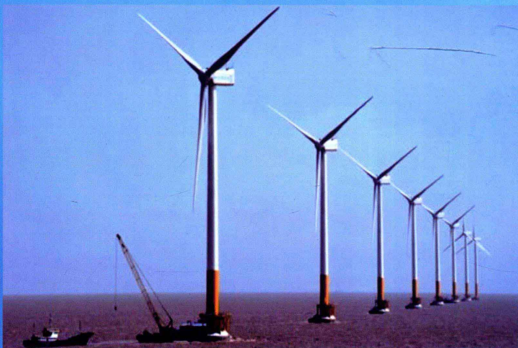
2010年7月6日，我国第一座大型海上风电场——上海东海大桥100兆瓦海上风电示范项目并网发电。风电场建设标志着我国大功率风电机组装备制造业跻身世界先进行列
