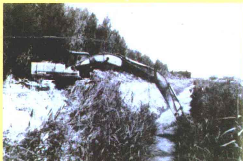
▶使用挖掘机对 老排水渠进行清淤。
