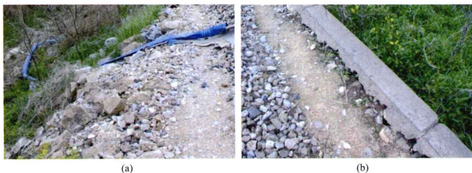
图 2-1 脱落式病害表现形态
