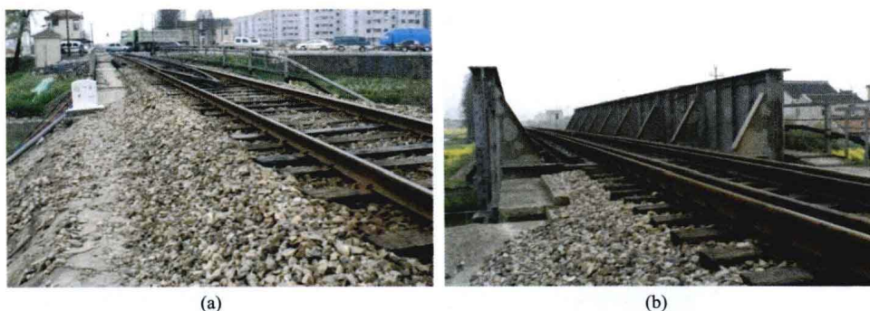
图 2-5 金山铁路路桥过渡段
