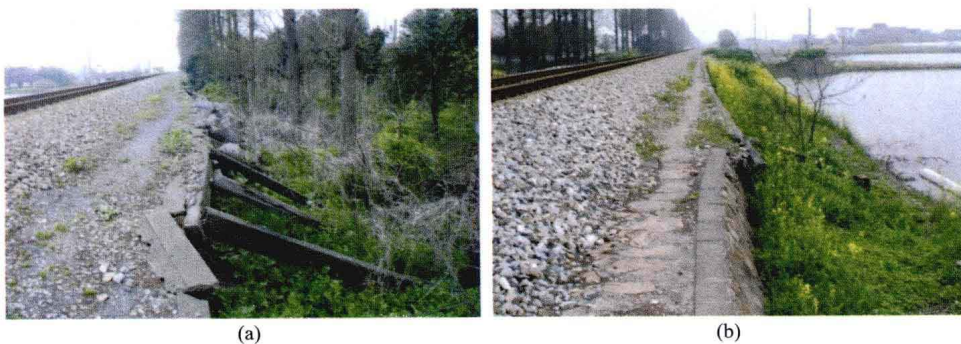
图 2-3 挤断型病害表现形态
