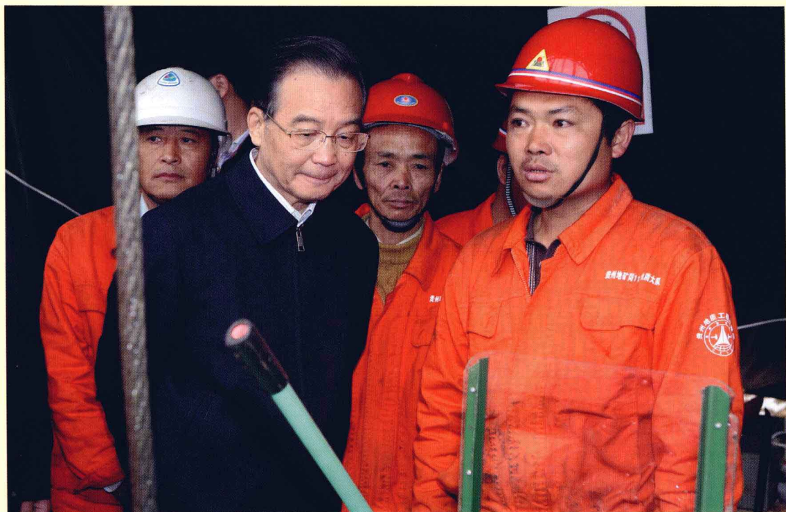
▲2010年4月4日，中共中央政治局常委、国务院总理温家宝在贵州兴义贵州省地质环境监测院找水打井施工现场考察抗旱救灾工作。
