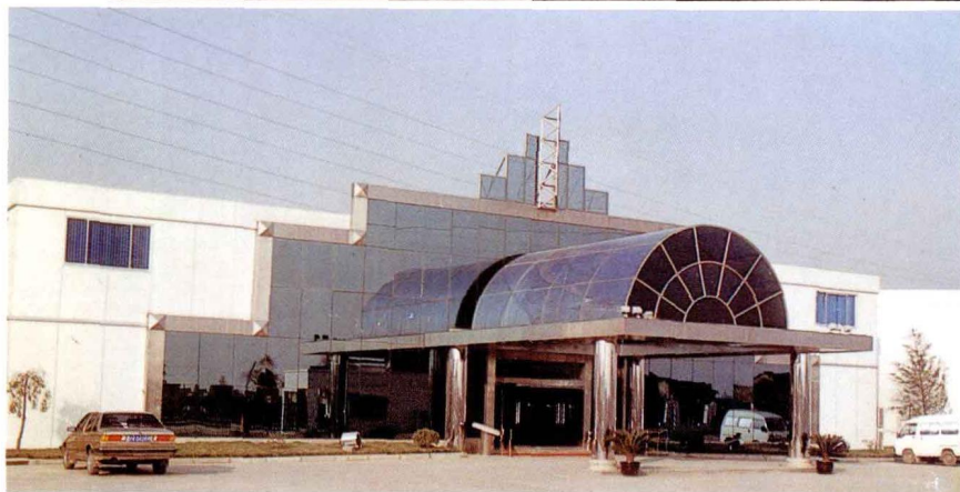
张江高科技园区在建设中。这是地处上海浦东新区龙东路1000号的张江高科技园区开发公司本部
