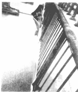
检修道钢板绞卷撕裂
