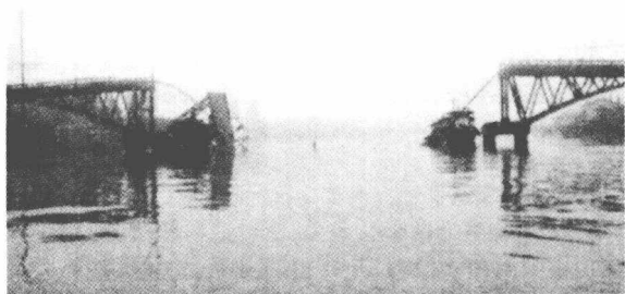
图 1-14 东汇大桥船撞事故
