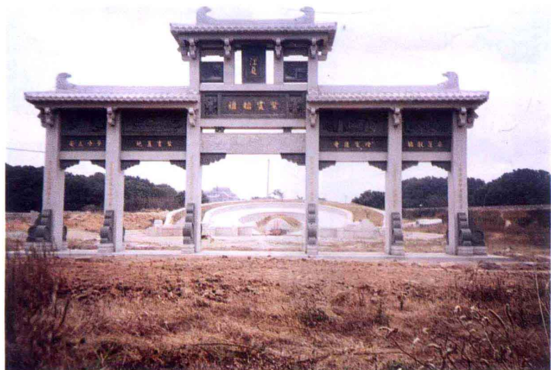
守恭公墓前新建成的牌坊
