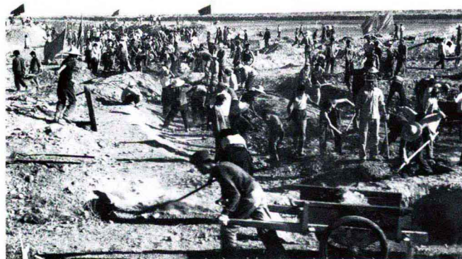
修建上游水库 (1960年)
