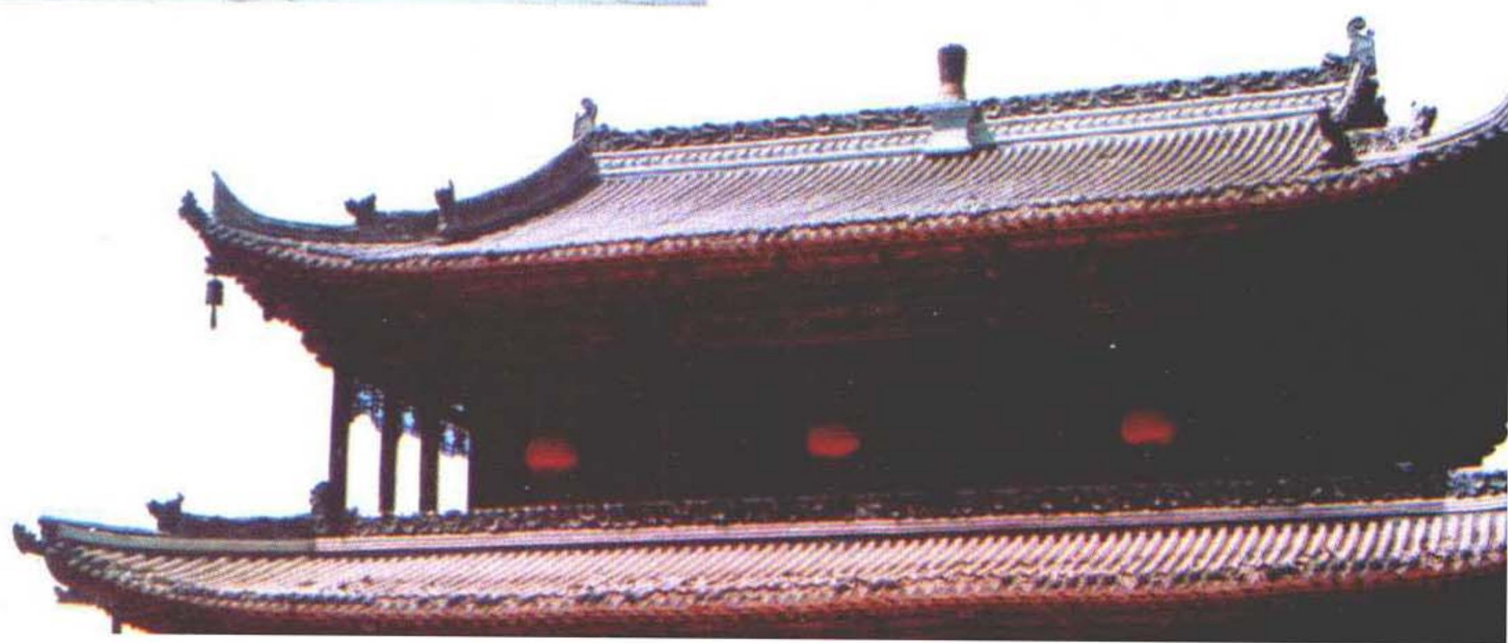
靖远寺大殿楼顶
