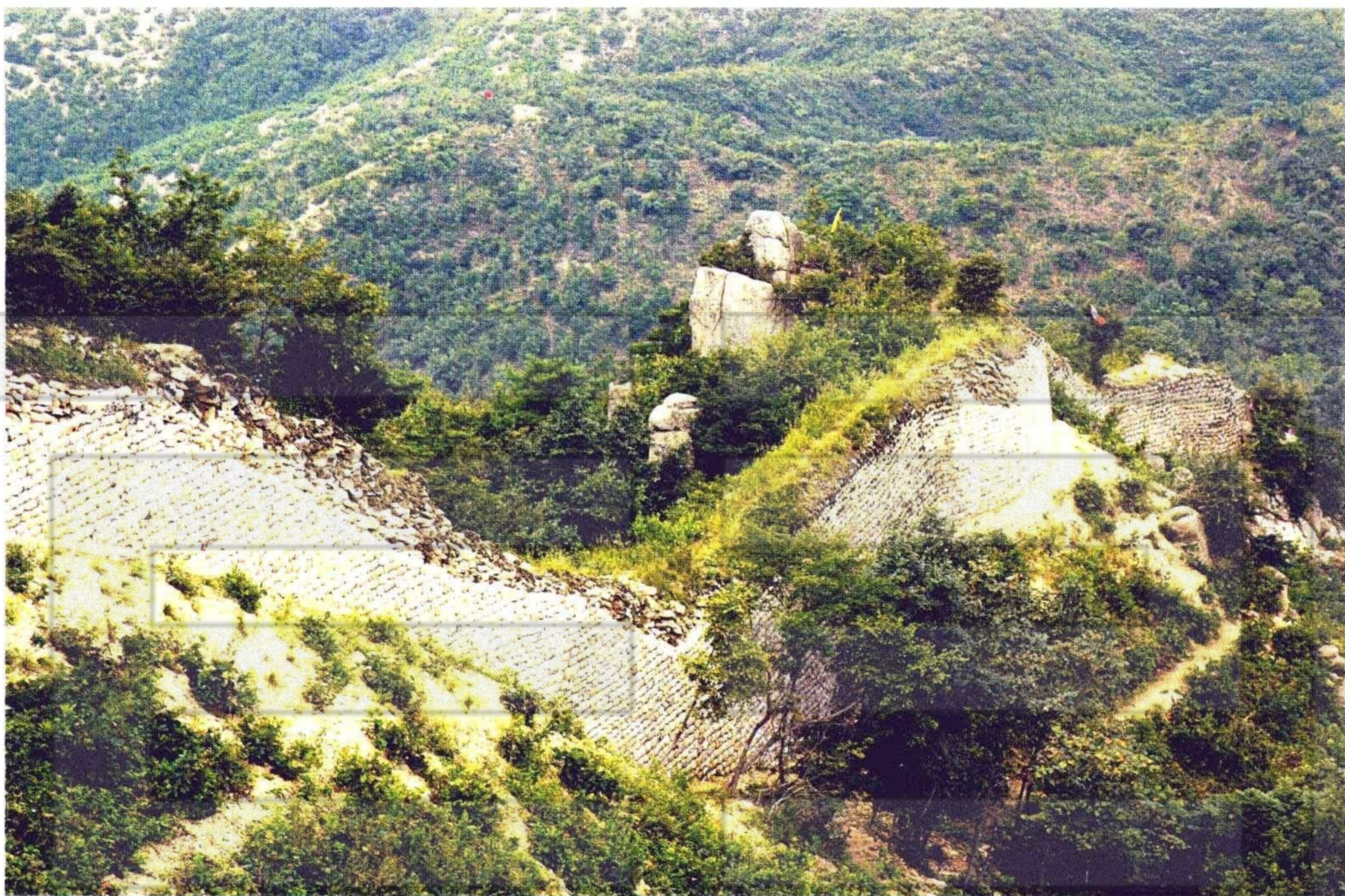
维修后的凤凰城山城城墙局部
