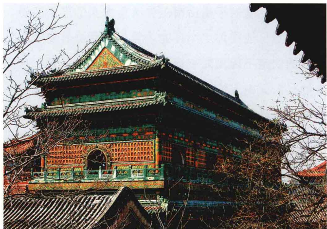
图020 北海大西天全琉璃无梁殿
