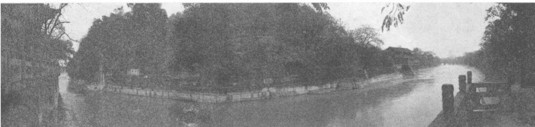
山口。因其形状酷似瓶口，故取名“宝瓶口”。“宝瓶口”的修建极大地解决了以往灌溉和分流的难题，但新的问题又出现了。岷江地势东面较高，江水难以流入“宝瓶口”，李冰父子经过一番考察，决定在岷江中修筑一个分水堰，将岷江水分成两个支流，一支顺江而下；另一支导入宝瓶口。但修建过程并非易事，分水堰必须十分坚固否则极易被湍急的江水冲走。李冰受到当地人巧用竹子的启发，将竹子编成竹筐，竹筐内装满鹅卵石沉入江中，周围再用大石头加固，形成了一个狭长的如鱼嘴形的小岛，因此获名“鱼嘴分水堤”。这样鱼嘴分水堰有效地把汹涌的岷江水分成两部分，内江水通过宝瓶
