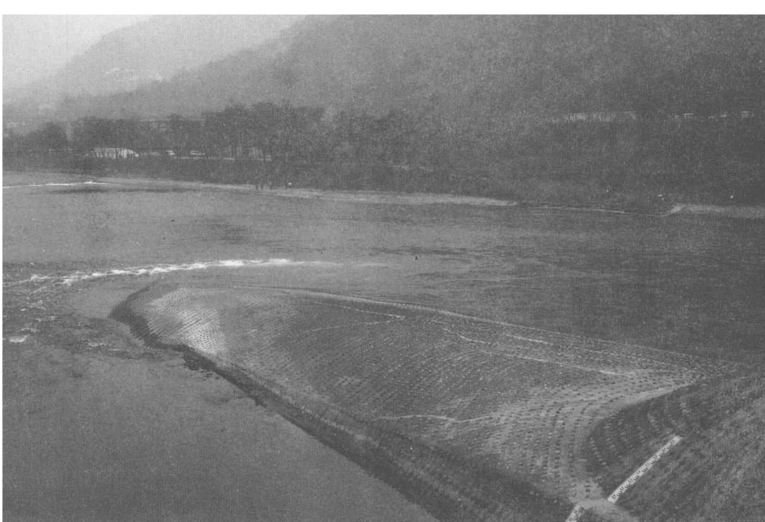
口灌溉成都平原，外江泄洪排洪。岷江水超过鱼嘴分水堰时夹带大量的沙石，时间一长就会阻塞内江和宝瓶口的入水通道，为了更好地分洪减灾，李冰等人又修建了一条“飞沙堰溢洪道”，保证岷江水中夹带的沙石都会流到外江中，不会阻塞内江和宝瓶口水道。
