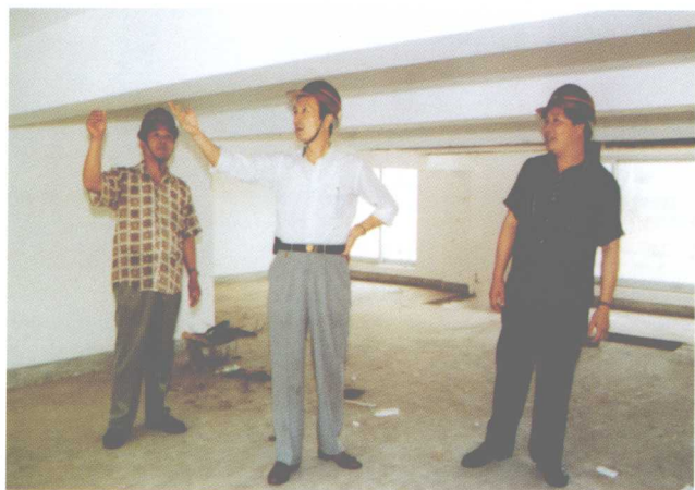
在楼房建筑工地
