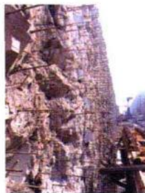
双线五级船闸高边坡施工技术，确保了山体的稳定
