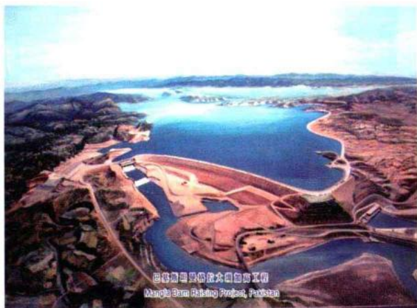
巴基斯坦曼格拉大坝加高工程
