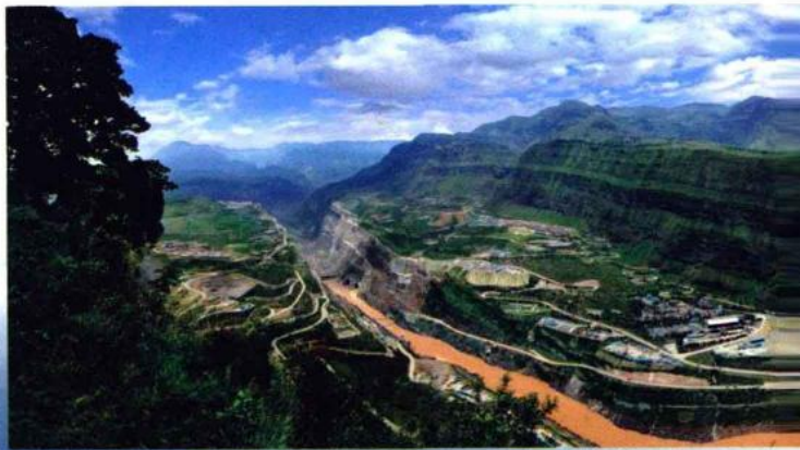
建设中的溪洛渡水电站
