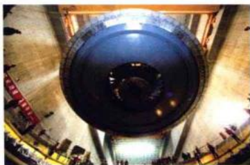
三峡电站转子吊装
