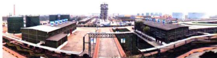
中原油田文二联合站全景
