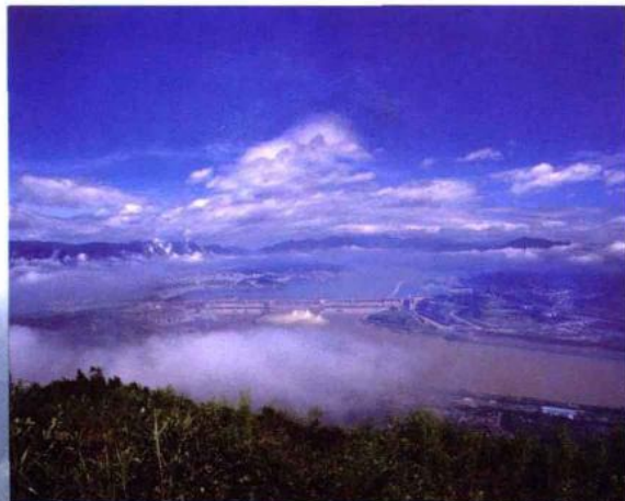
长工三峡水利枢纽
