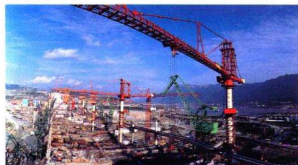
大坝混凝土快速施工技术的应用，极大提高了生产效率
