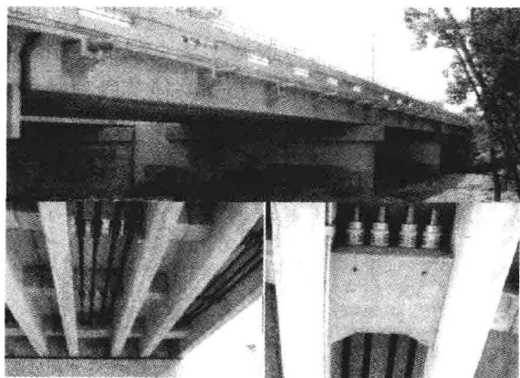
图 1-3 美国第一座 CFRP 体外预应力混凝土桥
