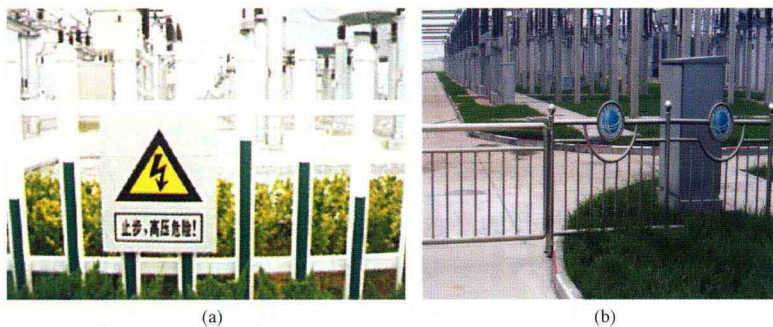
图 2 区域隔离围栏 (a) 塑钢；(b) 不锈钢
