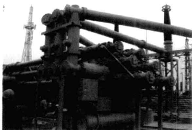
图 1-4 全封闭组合电器 (GIS)
