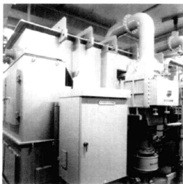
图 1-6 SF 6 变压器 (互感器, GIT)
