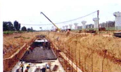
共同沟项目建设现场
