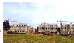
新筑新城项目建设现场
