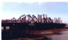
陆港大桥（东风桥）
