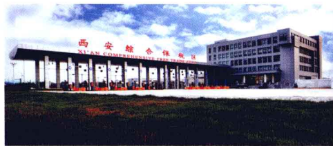
西安综合保税区 Xi'an Comprehensive Bonded Area
