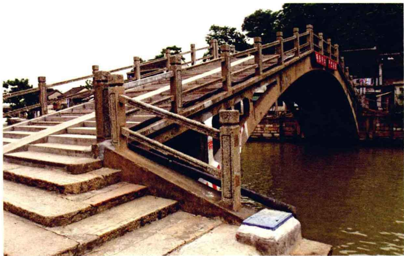
丁蜀镇的跨河桥
