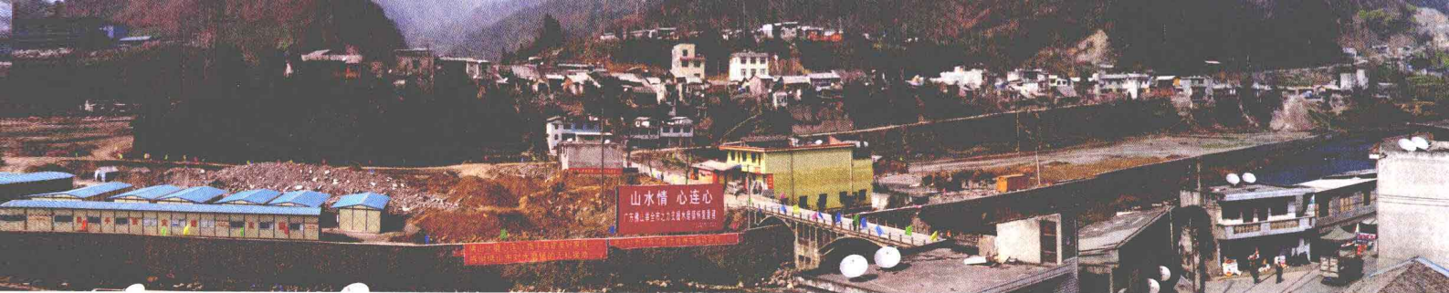
图1-1 震后的水磨是一片废墟
