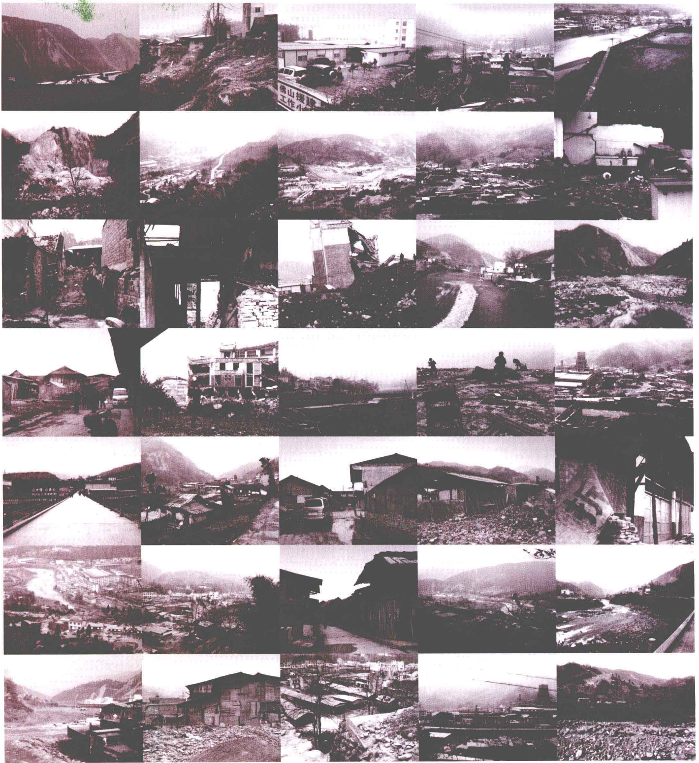
图1-2 震后的水磨是一片废墟
