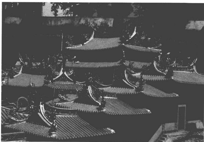
图 0-3 安溪罗内安山庙 层层铺陈的屋顶
