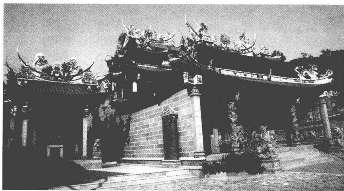
图 1-9 闽地热闹如戏台的宫庙建筑屋顶——厦门何厝顺济宫
