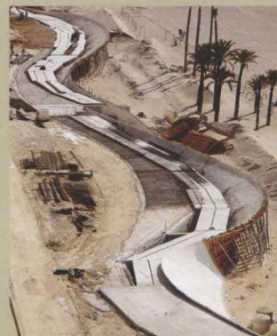
施工中的站台地基 platform foundation under construction
