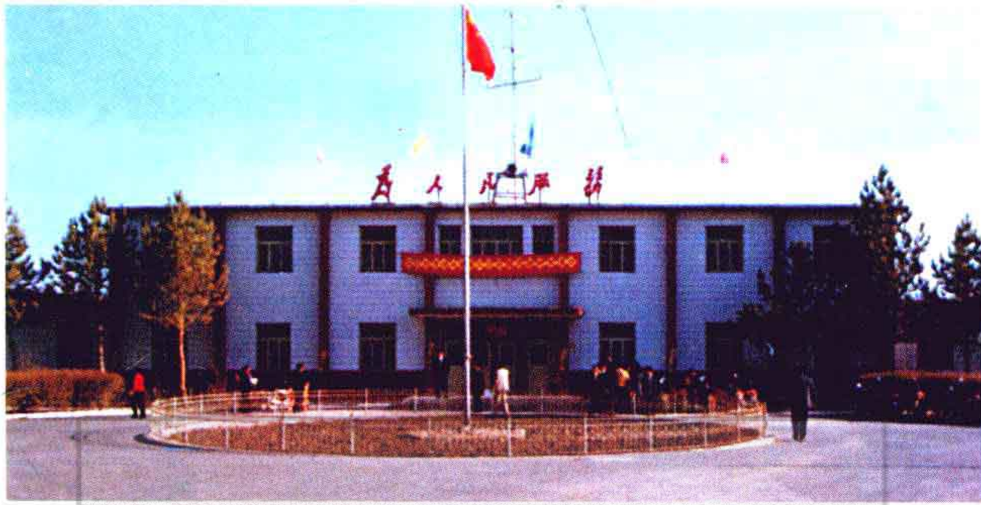
西山农牧场办公楼
