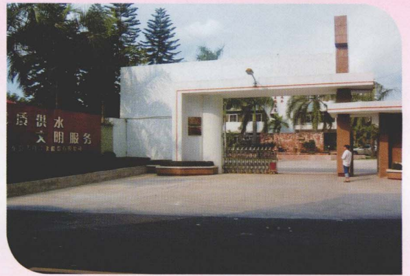
位于梨川辖区内1992年建成投产的东莞水厂（二水厂）
