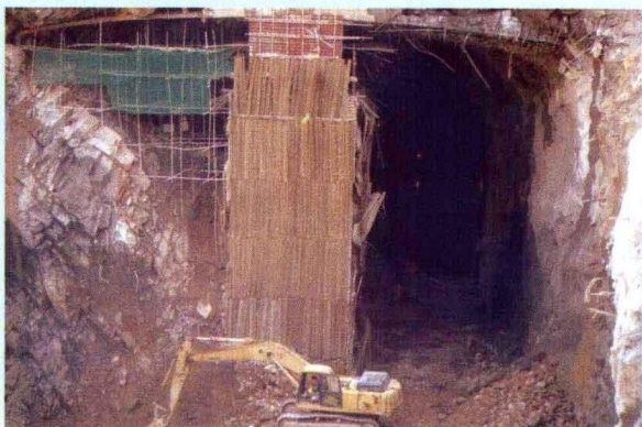
糯扎渡水电站3号导流洞进口渐变段采用“中隔墩法”分幅开挖
