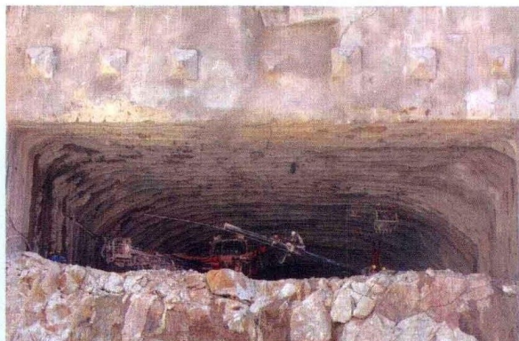
糯扎渡水电站2号导流洞渐变段，最大断面尺寸 27.6\text{m} \times 26.3\text{m} ，采用平顶一次开挖成型
