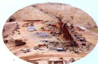
糯扎渡水电站上游围堰基础混凝土防渗墙快速施工
