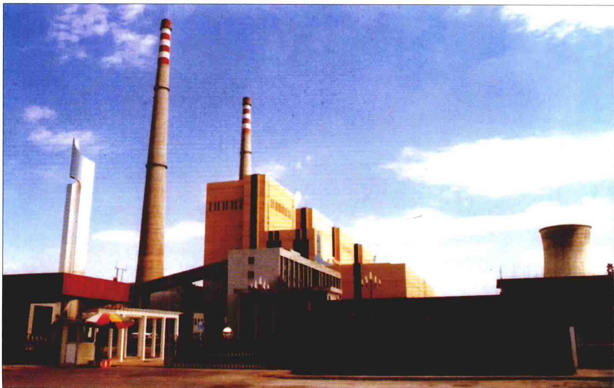
1995 年始建的华能公司北京热电厂
