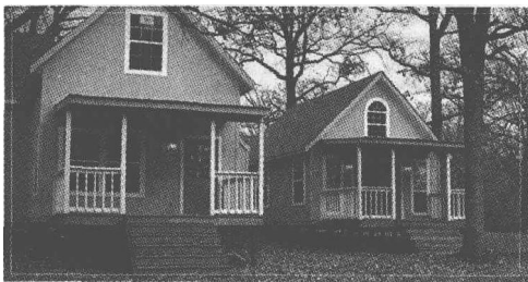
图 1-7 轻型钢结构住宅
