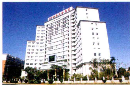
云南冶金集团办公大楼
