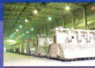
大型电解槽生产车间
