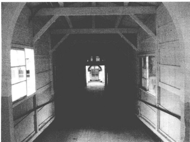
樂生院最重要歷史建築——王字型大樓中隔離有菌區與無菌區的長廊。
