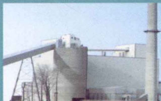
电站燃煤锅炉布袋除尘器
