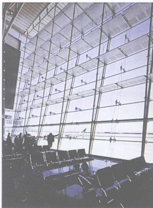
点支式玻璃幕墙局部（一）
