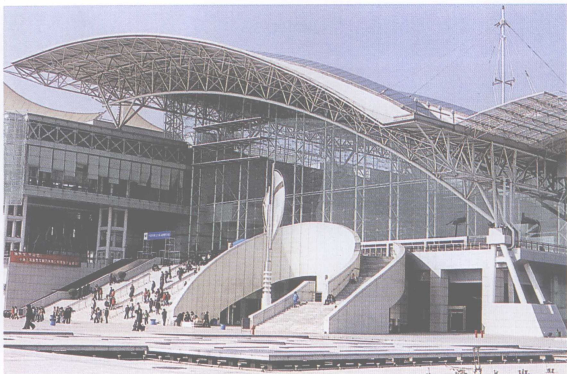
点支式玻璃幕墙外观
