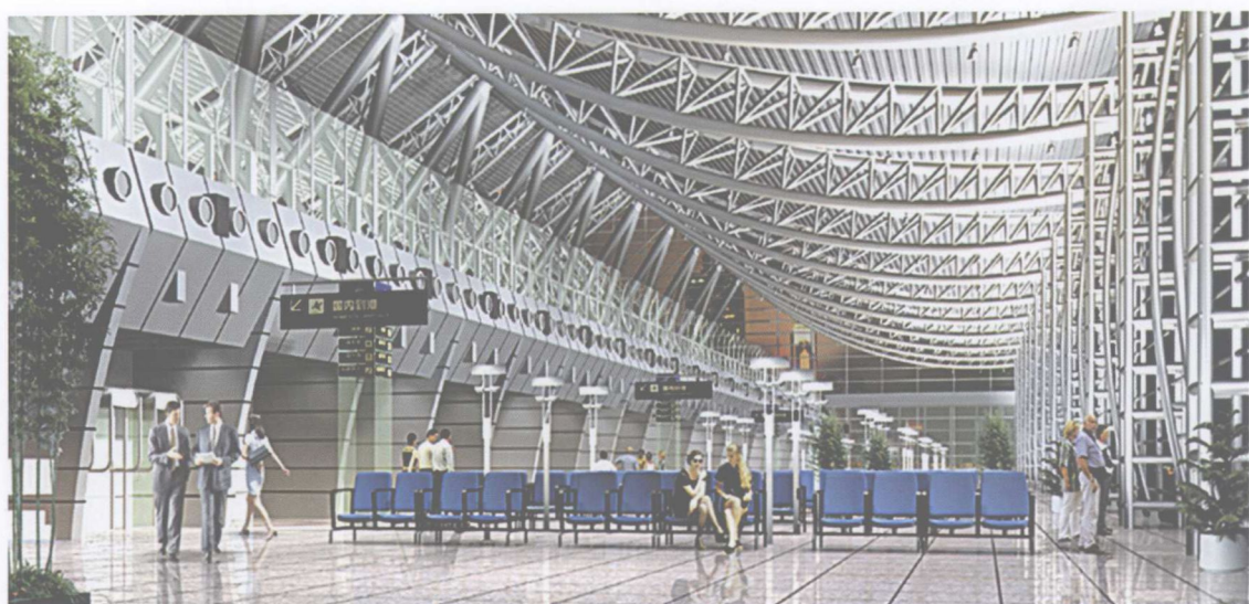
桁架式结构吊顶
