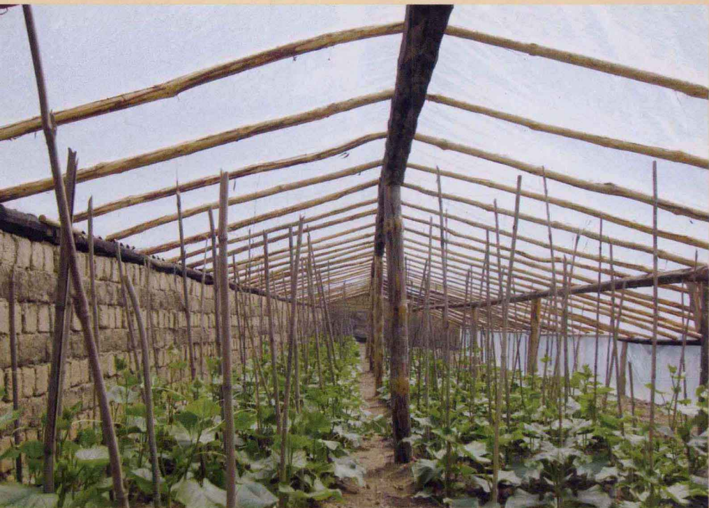
墙体大棚内部构造
